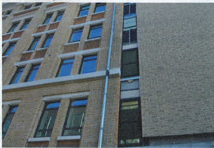
Sur la façade du silo donnant sur le canal, des bandes de béton encadrant les vitres soulignent les verticales et marquent la césure avec l'uniformité de l'ancienne bâtisse, constituée d'un tube en un seul tenant. Un panachage de briques permet de recouvrir le coloris aléatoire des anciennes briques nettoyées.
