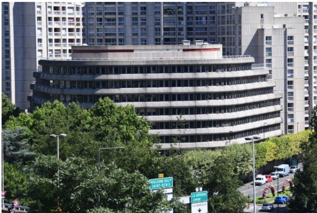
L'immeuble du Galion a été construit au début des années 80 – Defense-92.fr
