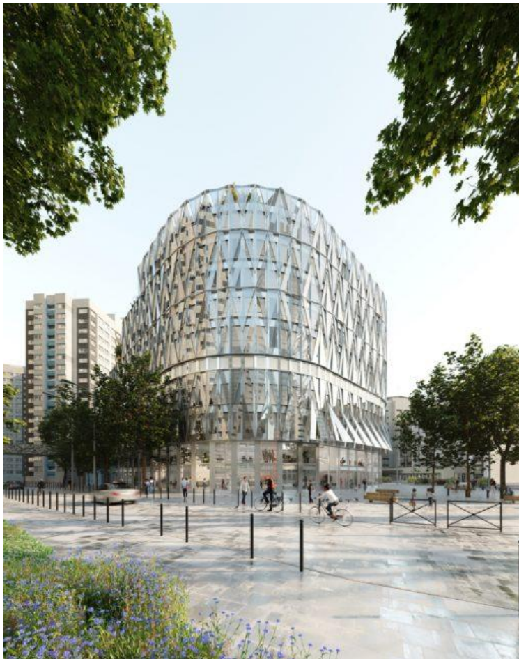
L'immeuble Galion rénové sera composé de dix étages – SAA Architectes
